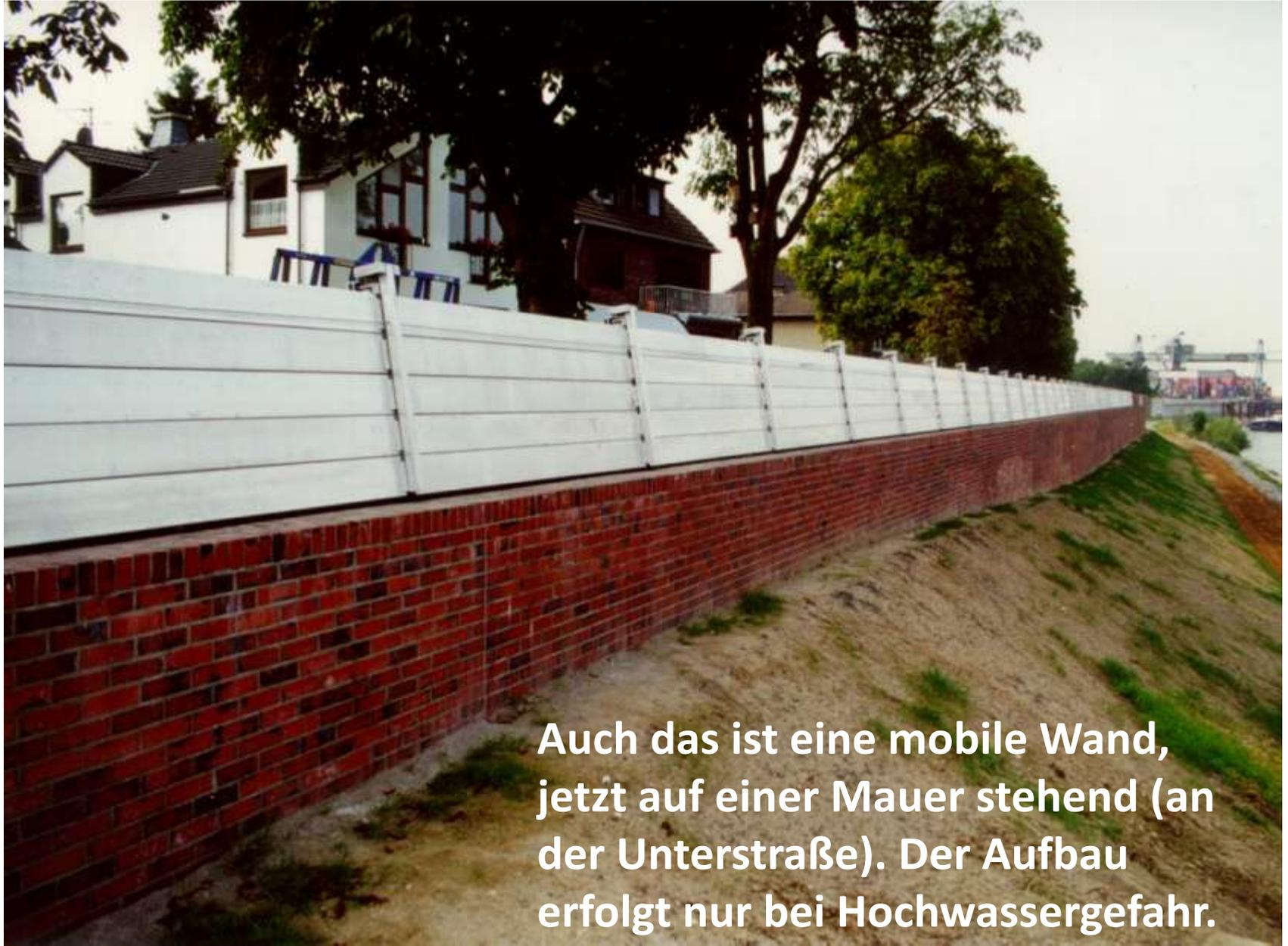
**Auch das ist eine mobile Wand, jetzt auf einer Mauer stehend (an der Unterstraße). Der Aufbau erfolgt nur bei Hochwassergefahr.**
