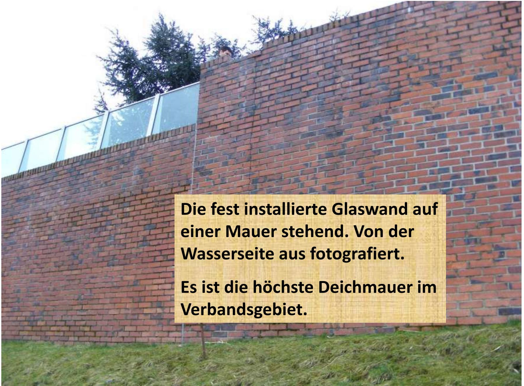
**Die fest installierte Glaswand auf einer Mauer stehend. Von der Wasserseite aus fotografiert.**
